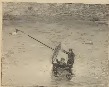
Fig. 1. - Prueba del submarino Goubet practicada en Cherburgo en 1.º de febrero de 1890. El Goubet cerrando su porta. (De una fotografía)
